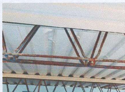
foto 10 : Mantenimiento a estructura de aulas cepillado, lijado y aplicación de pintura
