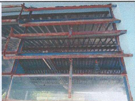
foto 10 : sustitución de ventanas de metal por daños de óxido por venatnas Pvc y reparación de puertas
