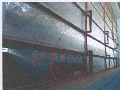
foto12: sustitución de ventanas de metal por daños de óxido por venatnas Pvc y reparación de puertas
