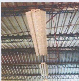
Foto 7: Sustitución de cableado eléctrico sin funcionamiento 150 metros lineales
