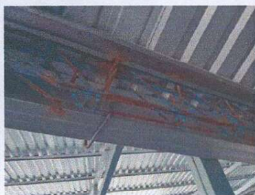
foto 9: Mantenimiento a estructura de aulas cepillado, lijado y aplicación de pintura.
